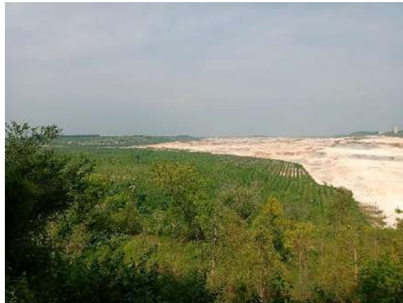
Gambar 94 Kawasan Lantai Reklamasi PT Semen Indonesia (Persero) Tbk Pabrik Tuban Tampak Dari Atas (Lantai Reklamasi tahun 2014 dan Lantai Reklamasi 2016)
